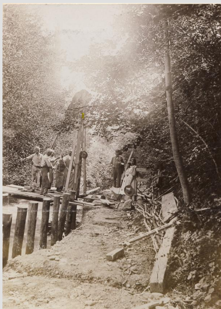
Travaux d'endiguement - APV/AMG08
