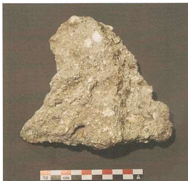
Figure 11. Mortier gris friable, à nodules de chaux, appartenant à la maçonnerie Us31.
